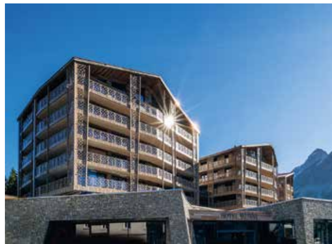
L'hôtel quatre étoiles Valsana est entièrement neutre en termes d'émissions de CO 2 , est certifié Swisustainable et se chauffe sans utiliser de combustibles fossiles.
